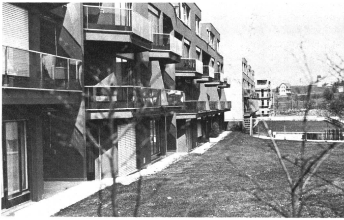
Vorgartenbereich der Erdgeschosswohnungen.
