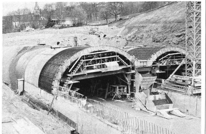
Blick auf die Baustelle des Tunnels Eich der N2 am rechten Ufer des Sempachersees. Aushub, Betonieren und Abdichten erfolgen in einem Taktverfahren. Nach dem Ausheben der Baugrube und dem Deponieren des Aushubs wird die Betonsohle erstellt. Anschliessend werden zuerst die Wände (Seite und Mitte) betoniert, die ihrerseits die stark armierten Betongewölbe aufnehmen. Darüber wird direkt die Sarnafil FP-Dichtungsbahn in einer Stärke von 4 mm verlegt. Die Dichtung schliesst beidseitig an vorher verlegte Drainageleitungen an. Über der Dichtung wird direkt das Aushubmaterial wieder eingeschüttet (Foto: Sarna Kunststoff AG, 6060 Sarnen).
