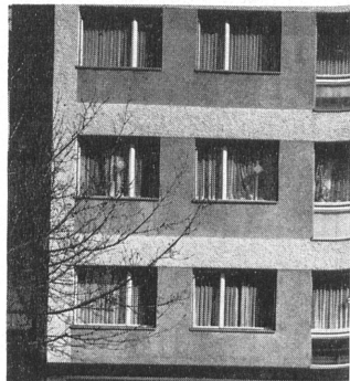
Wärmegedämmtes Austauschfenster aus Aluminium
