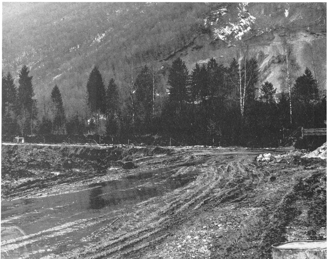
Ansicht der Pilotanlage auf dem Areal der Ciba-Geigy AG in Monthey. Die Pilotanlage ist schon beinahe gefüllt, Blick auf den letzten Abschnitt. Die ausgedienten Autoreifen beschweren die KDB Sarnafil FP und schützen sie damit vor dem Abrutschen, da die Böschung in der Pilotanlage etwas zu steil gewählt worden ist. Im Hintergrund Teilansicht der chemischen Werke Ciba-Geigy AG in Monthey. (Foto: Sarna Kunststoff AG, Sarnen)
