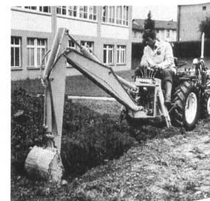
Arbeiten mit dem vollhydraulischen Heckbagger
