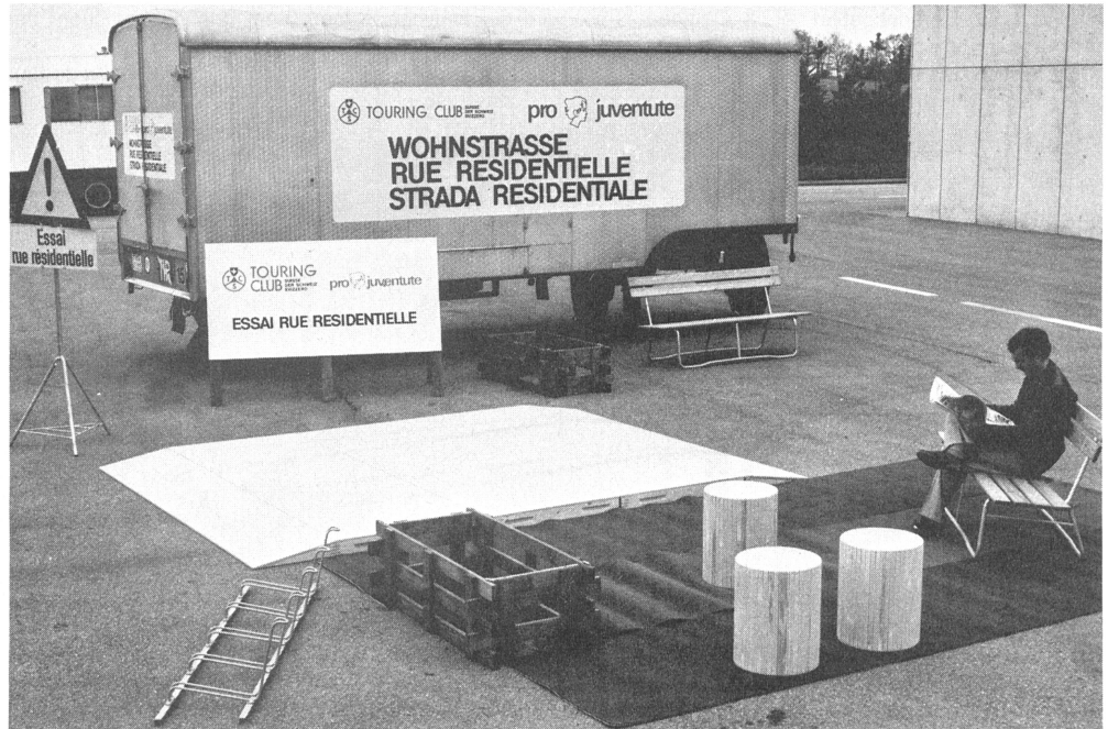
Die Elemente des Wohnstrassen-Sets bestehen aus Rampen zur Konstruktion von Schwellen, Rosten zum Herstellen simulierter Blumentröge, Holzblöcken für Abgrenzungen, Bänken, Rasenmatten, Baumatrappen usw. Der Massstab 1:1 ermöglicht eine wirklichkeitsgetreue Darstellung einer Wohnstrasse.
