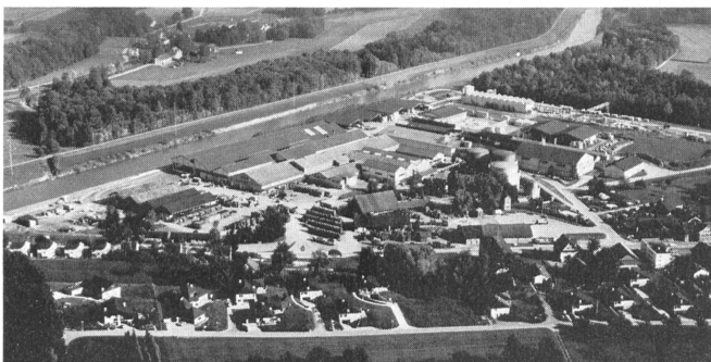
Blick auf das mit einem Aufwand von 30 Mio. Franken erneuerte und auf vollautomatische Produktion ausgebaute Werk der Zürcher Ziegeleien in Istighofen TG, in dem täglich über 80000 Tondachziegel hergestellt werden.
