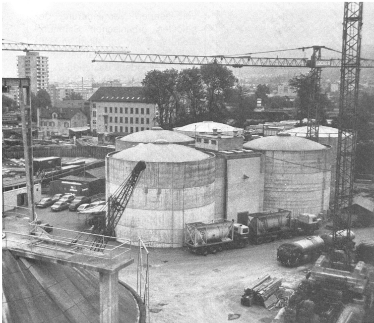
Abb. 7. Blick von der bestehenden Faulanlage zur Voreindickeranlage. Vorn die drei bestehenden, dahinter die beiden neuen Behälter.
