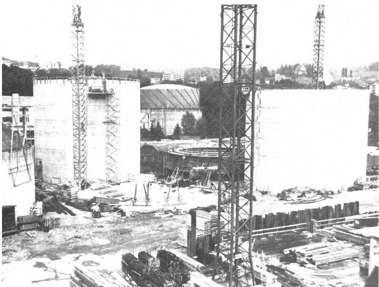
Abb. 8. Die vier neuen Behälter der Vorfaulanlage im Bau. Am rechten Bildrand ist ein Behälter der bestehenden Faulanlage sichtbar.
