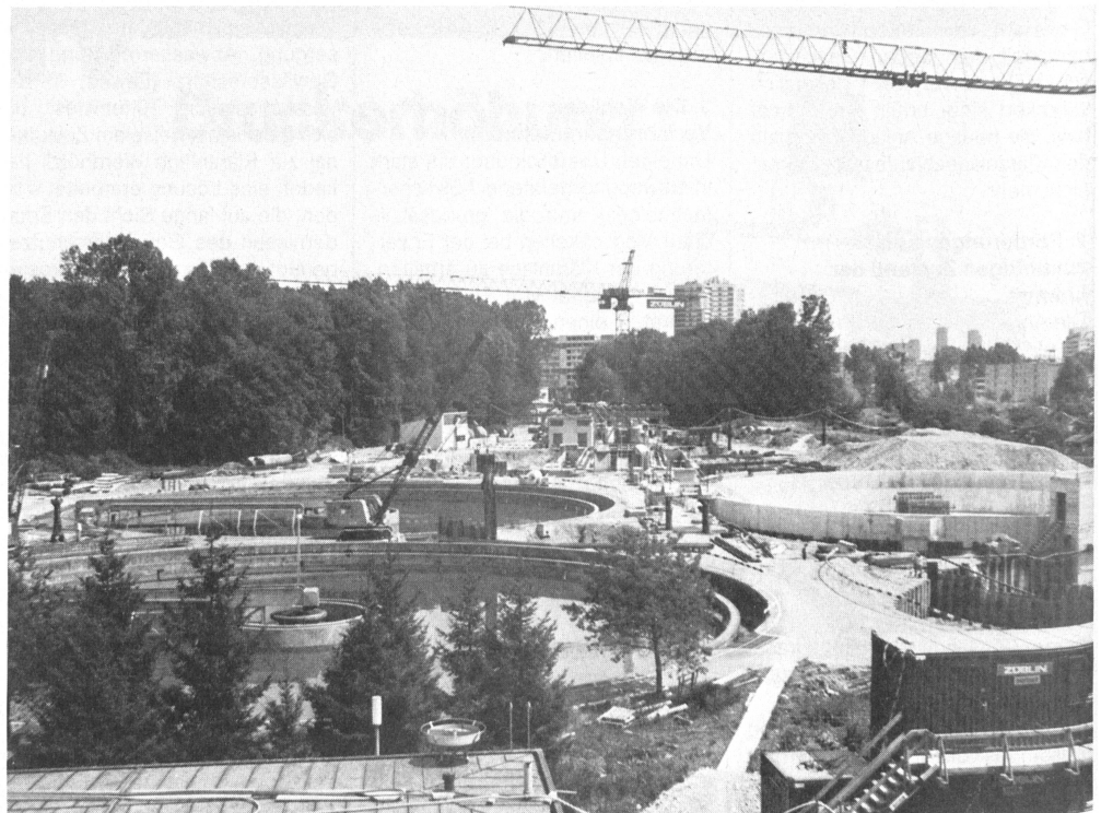
Abb. 3. Links die bestehenden Vorklärbecken, rechts die beiden neuen im Bau befindlichen.
