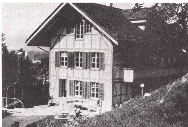
Saniertes Wohnhaus aus der Mitte des 19. Jahrhunderts (oben: vorher, unten: nachher). Sanierungskosten: Fr. 430.-/m 3 (Preisindex 1982).
