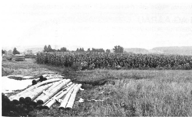
Abb. 4. Bereitgelegte KDB aus Sarnafil-FP (LDPE), extrudiert in 2 mm Stärke. Die Bahnen sind doppelt gegen die Mitte eingerollt. Gleichzeitig wurden Bänder eingerollt, die das nachherige Aufziehen auf beide Böschungen erleichtern.
