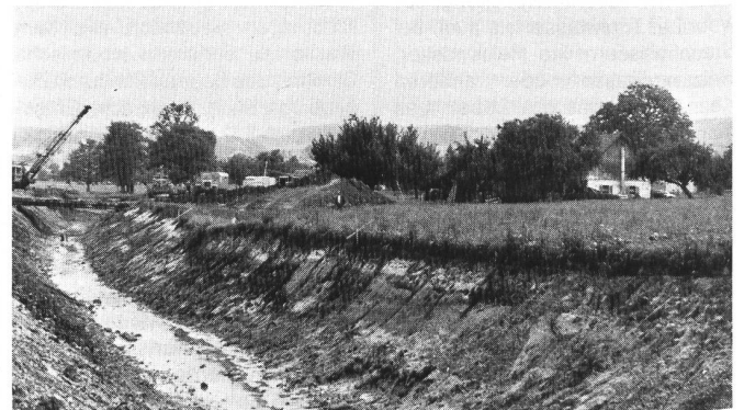
Abb. 1. Der mit Bagger ausgehobene Kanal, bereit für das Einlegen der Kunststoff-Dichtungsbahnen. Man beachte den sehr heterogenen Boden, in Bildmitte unten Bäume und Äste aus längst vergangenen Zeiten.
