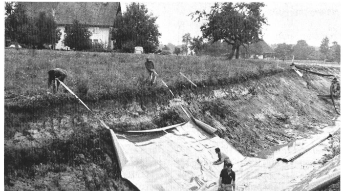
Abb. 7. Aufziehen der in der Kanalachse verlegten KDB mit Hilfe der eingerollten Bänder.
