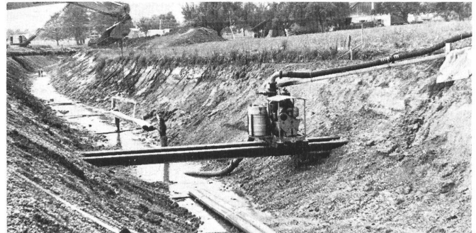
Abb. 6. Mit dem Bagger wird eine rund 10 m lange Kunststoff-Dichtungsbahn Sarnafil FP abgesenkt und in der Kanalachse verlegt. Die beiden Enden der Bahn ruhen nach dem Absenken auf vorher bereitgelegten Brettern, wodurch das nachfolgende Zusammenschweißen zweier Bahnen erleichtert wird.
