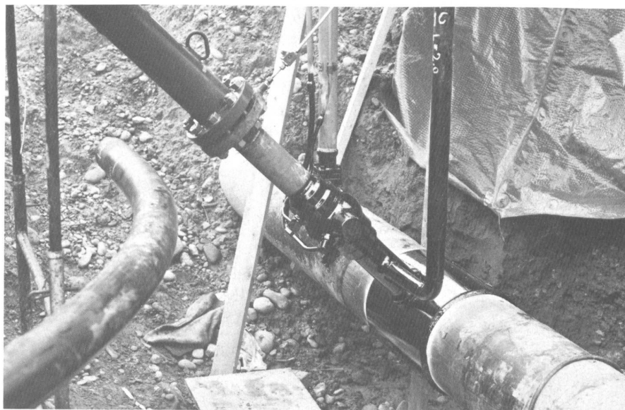
Anbringen des zweiten Versorgungsstrangs von Zofingen an der Swissgas-Leitung unter vollem Betriebsdruck.
