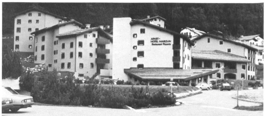
Aparthotel Margun in Surlej-Silvaplana: Neubau im Rahmen einer Quartiergestaltungsplanung. Vielfach werden nicht nur für traditionell geführte Betriebe, sondern auch für Aparthotels baugesetzliche Erleichterungen gewährt. Solche sind aber höchst gefährlich, wenn keine hinreichende Sicherung des hotelmässigen Betriebs besteht und die Gestaltung der Bauten keinen erhöhten Qualitätsanforderungen genügt.
