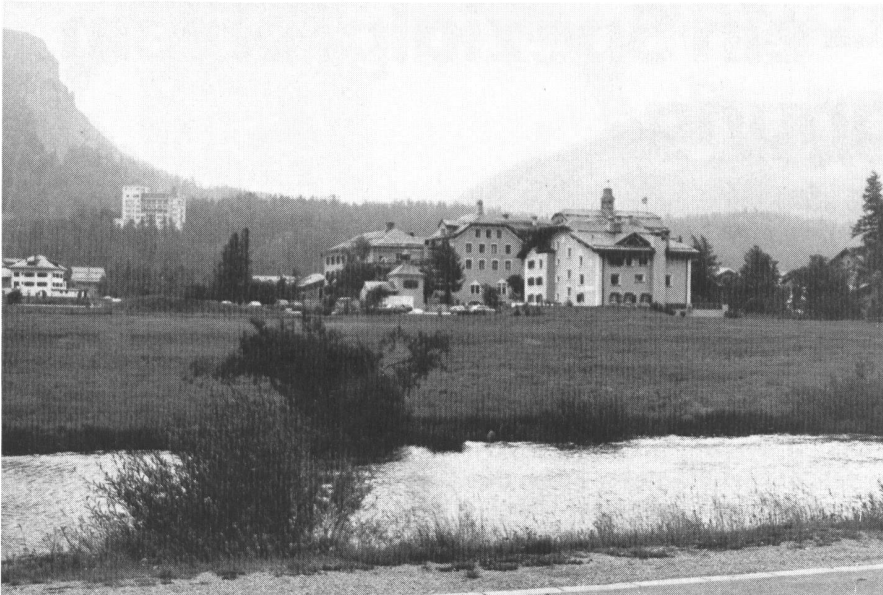
Hotel Margna in Sils Baselgia: eine geglückte Sanierung. Der Apart-Neubau mit Personalzimmern erbrachte die finanziellen Mittel für die Erneuerung des traditionell geführten Hotels. Diese Finanzierungsform ist positiv zu beurteilen, sofern damit ein traditionell geführtes Hotel saniert werden kann, der hotelmässige Betrieb sichergestellt ist und keine grösseren Einschränkungen in der allgemeinen Vermietbarkeit der Zimmer resultieren.
