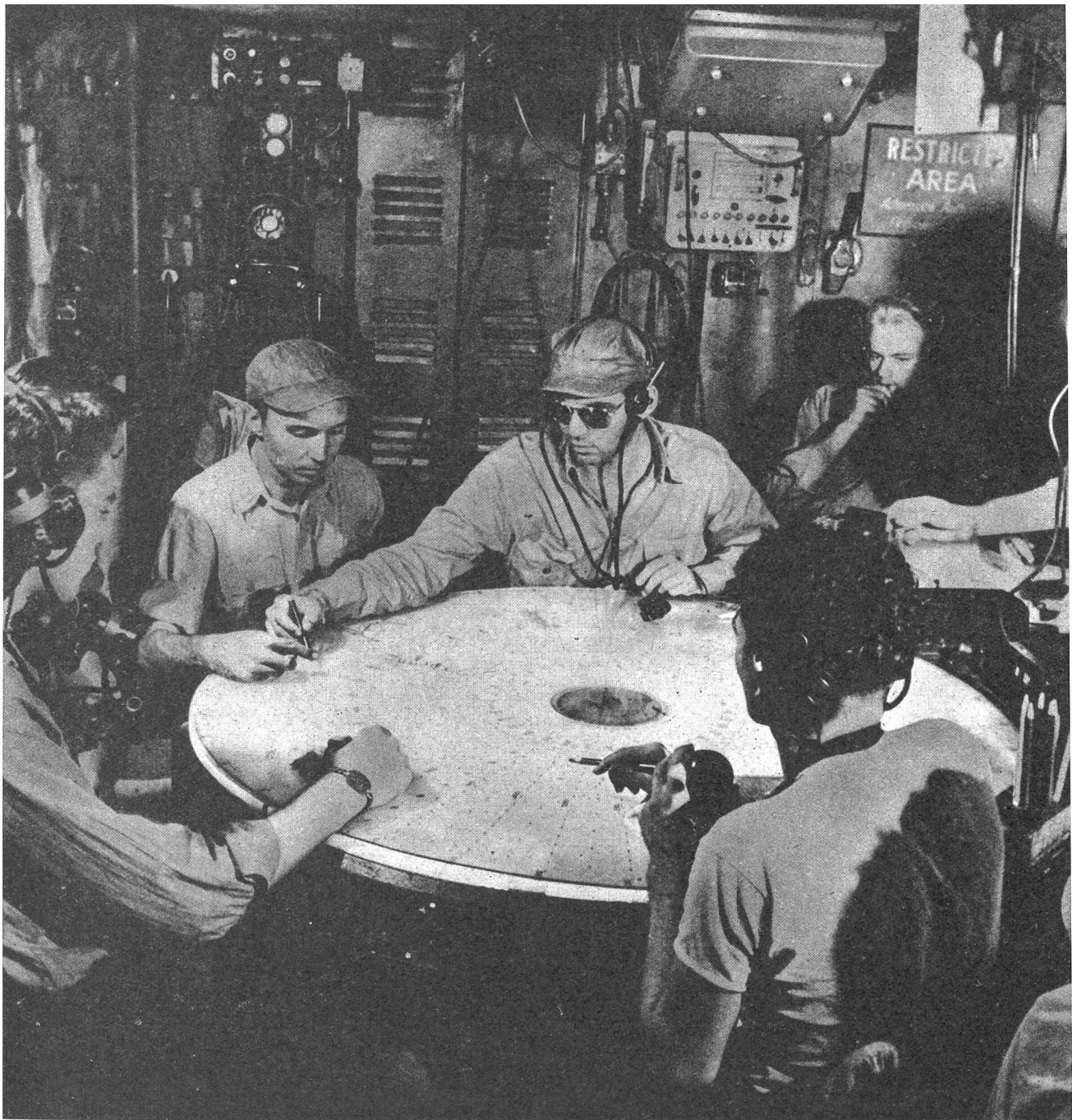
Im Innern der «Radar»-Auswertungszentrale eines amerikanischen Flugzeugträgers, der gegen Japan eingesetzt war. Mit «Radar» werden japanische Stellungen ermittelt und fortlaufend in die Karte eingetragen.
