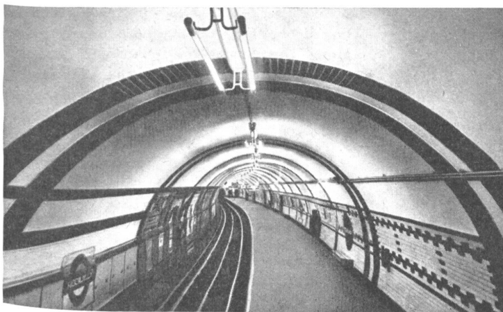
Bild 3: Leuchtstofflampen im Piccadilly-Bahnhof der Londoner Untergrundbahn
