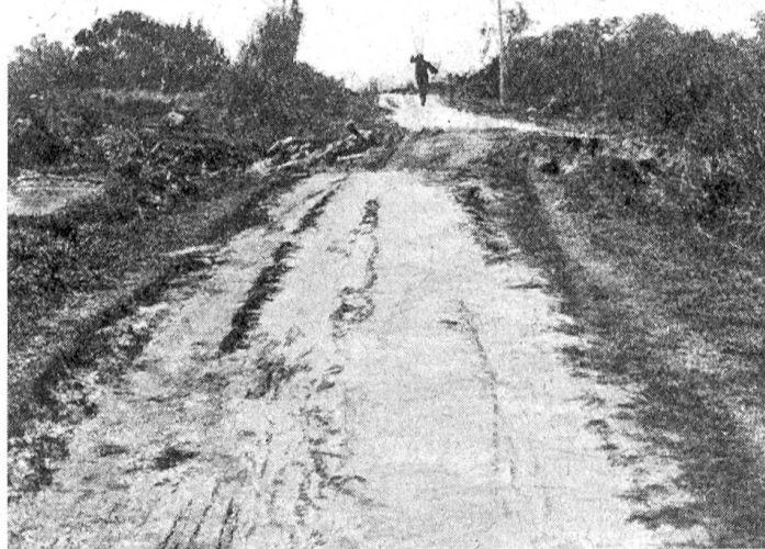
Aufgerissene Straße auf Formosa
