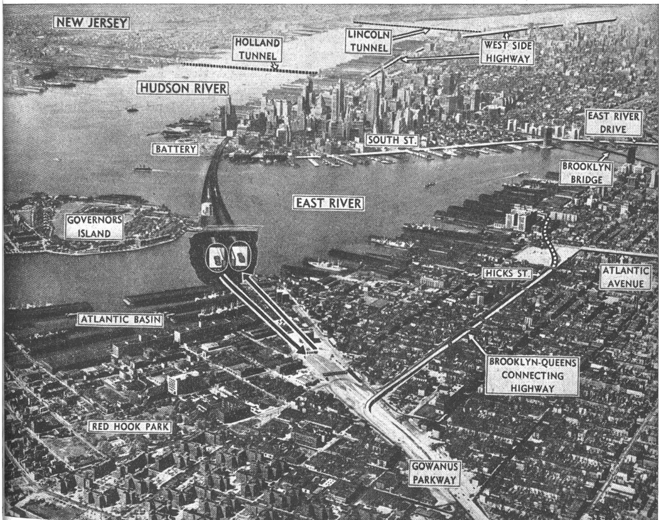
Abb. 1. New York City mit dem von Brooklyn auf Long Island (im Vordergrund) nach der Südspitze von Manhattan (im Mittelgrund) verlaufenden Brooklyn-Battery-Tunnel (Photo: „Neue Zeitung“)
