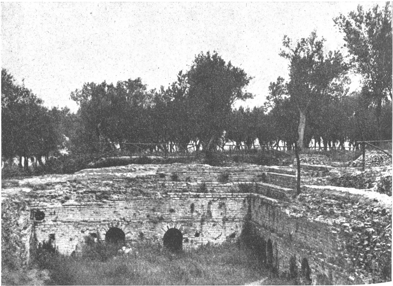
Ein archäologisches Unikum, dessen einstige Bedeutung heute noch nicht klar erkannt ist, stellt die „Piscina“ dar, die am Süden der Ruinen liegt und sich als großes, ziegelgeplastertes Bassin zeigt. Die umgebenden schmalen Gänge waren vielleicht Heizkanäle für das Wasserbecken
