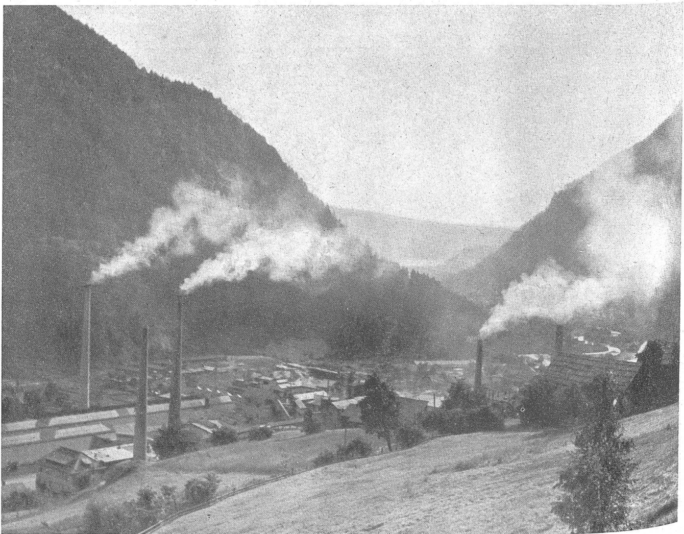
Abb. 6. Gesamtansicht des Magnesitwerkes Radenthein (Kärnten)
