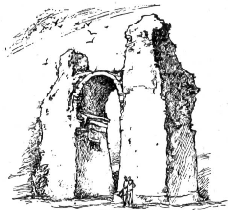
Abb. 1. Das „Heidentor“ bei Petronell mit seinem 6 m weit gespannten Ziegel-Gewölbebogen zwischen zwei massigen Türmen ist nur einer der vielen antiken Ziegelbauten, die Jahrtausende überdauerten
