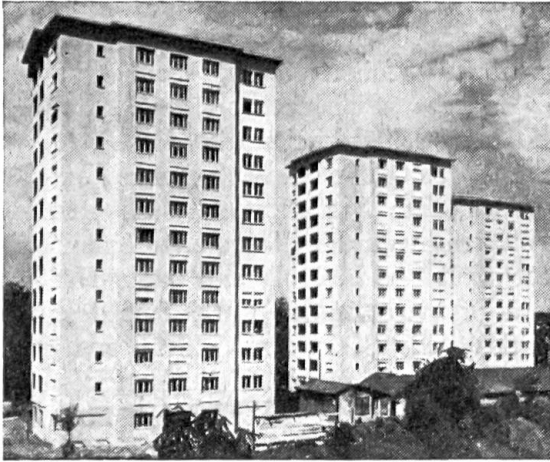
Abb. 6. Die Hochhäuser in Basel
