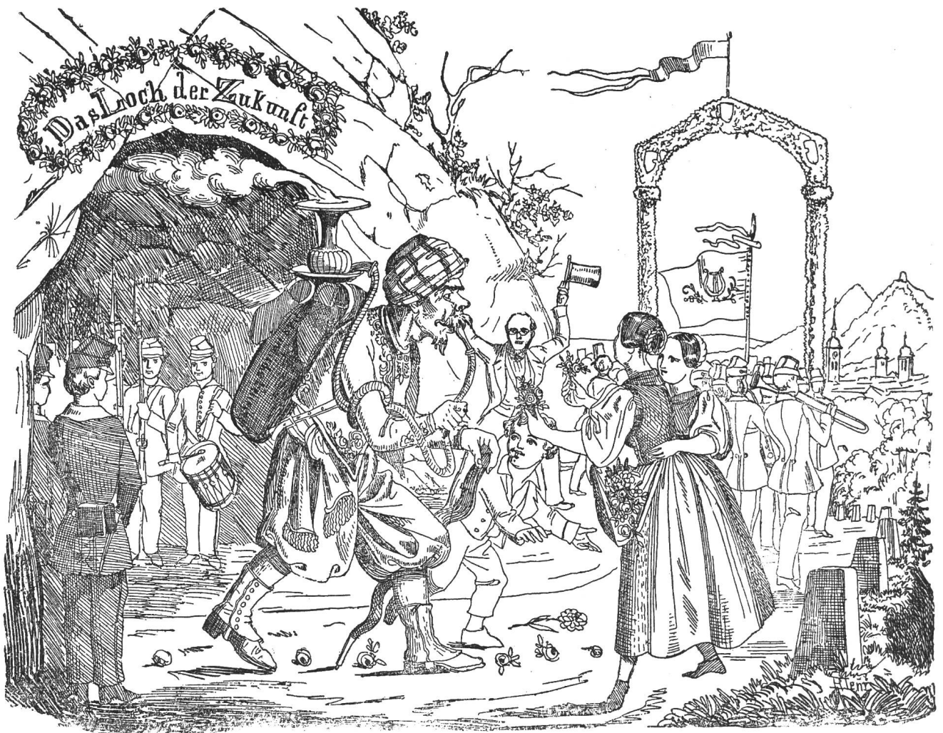
I. Die Ankunft des ostindischen Helleisens beim Ausgange des Hauenstein-Tunnels.
