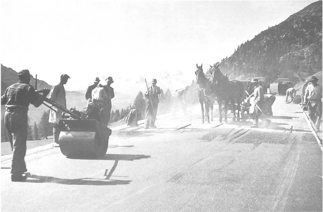
Abb. 8: Strassenausbau auf dem Julier
