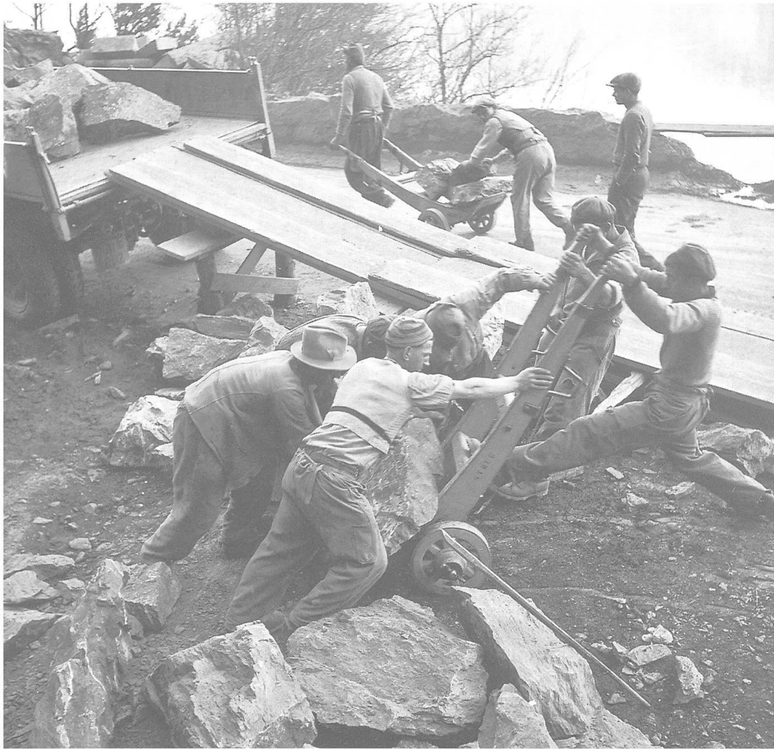
Abb. 5: Strassenausbau bei Arosa
