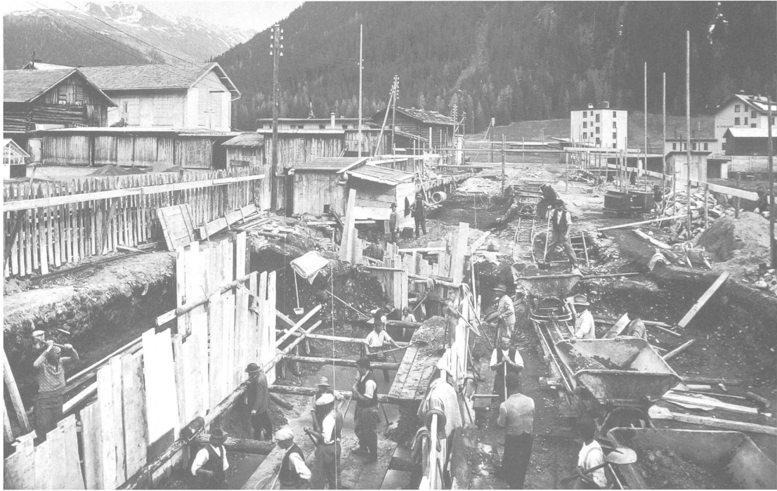
Abb. 3: Das Eisbahngebäude von Architekt Rudolf Gabarel, frühestes und bedeutendstes Beispiel für Arbeitsbeschaffung in Davos (1934). Aushub- und Fundamentierungsarbeiten
