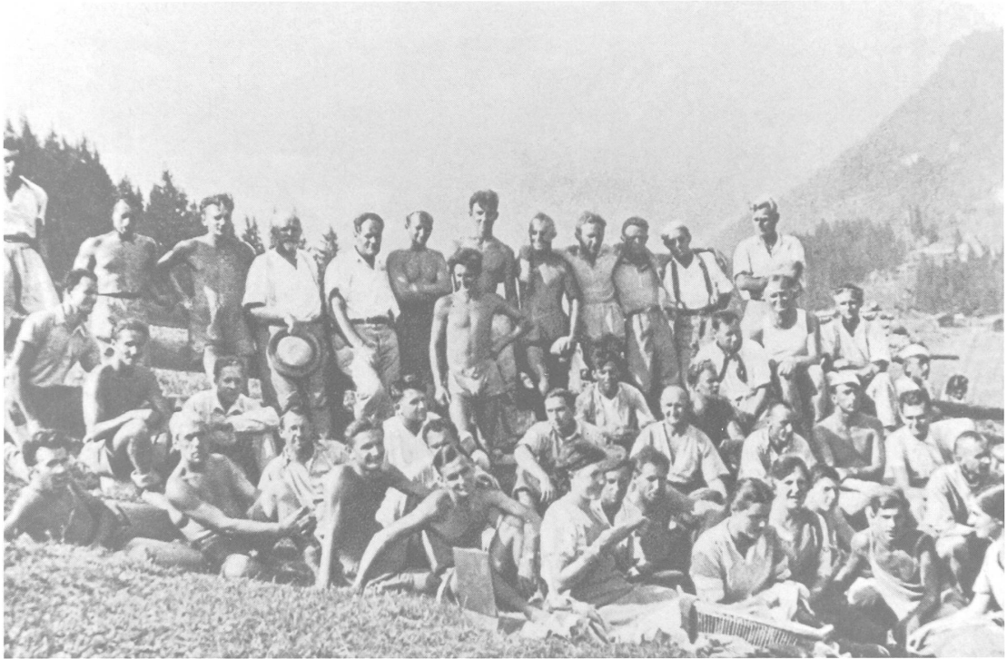
Abb. 10: Internationaler Hilfsdienst. Aufräumarbeiten in Litzirüti
