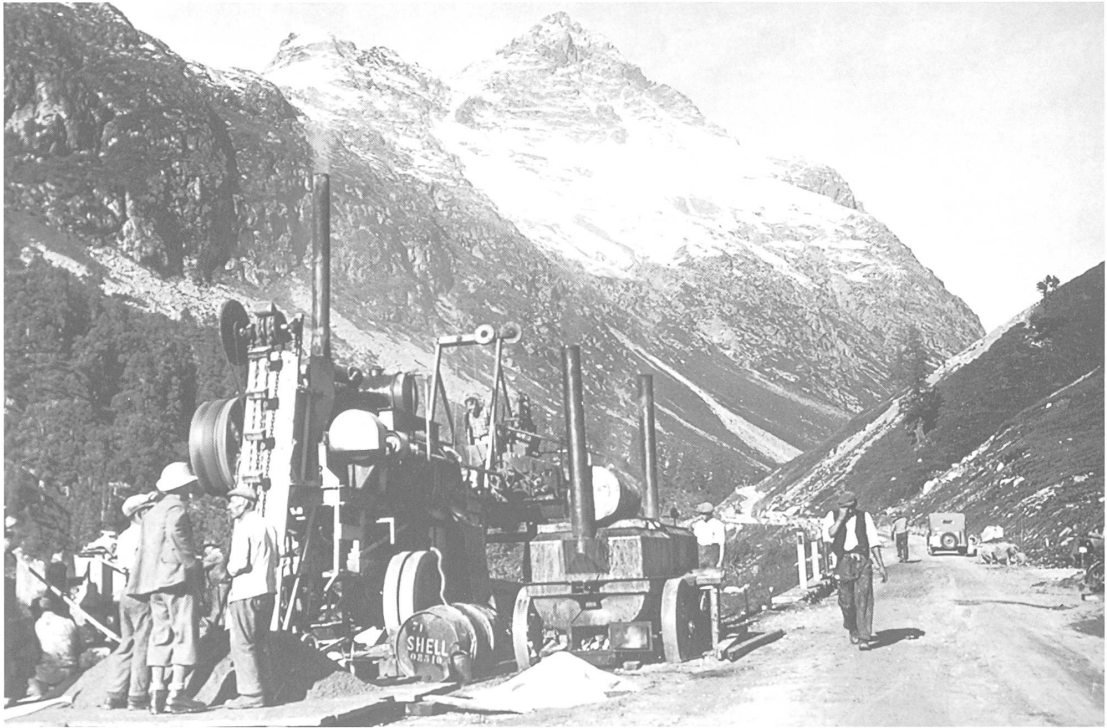
Abb. 7: Strassenausbau auf dem Julier
