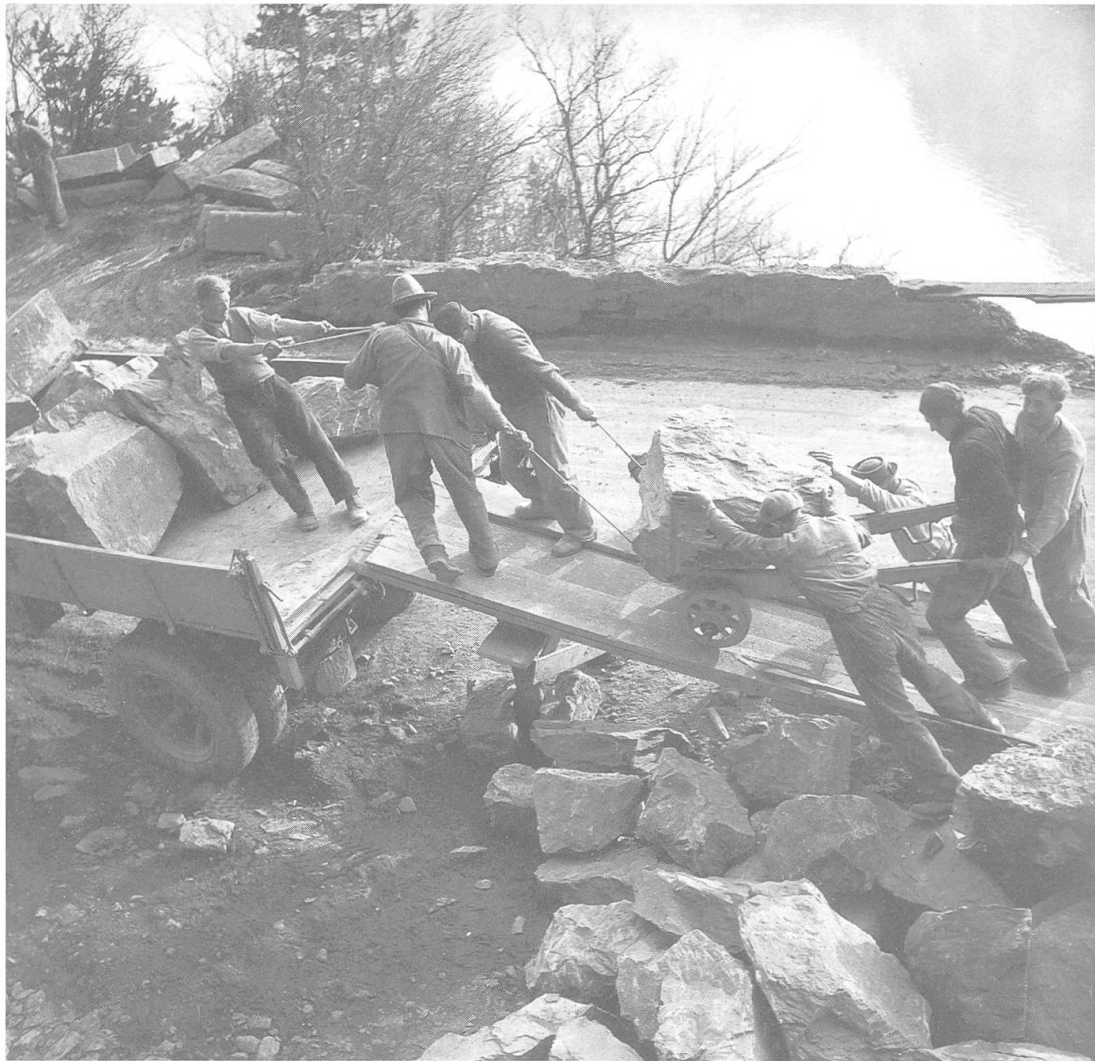
Abb. 6: Strassenausbau bei Arosa
