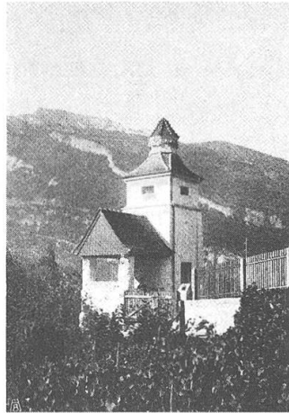
TRANSFORMATOREN- HÄUSCHEN IN CHUR. Erbaut 1906 von den Ar- chitekten Schäfer & Risch in Chur UNE TOUR POUR LA TRANSFORMATION DE L'ÉNERGIE ÉLEC- TRIQUE, A COIRE. (Ar- chitectes Schäfer & Risch .)
