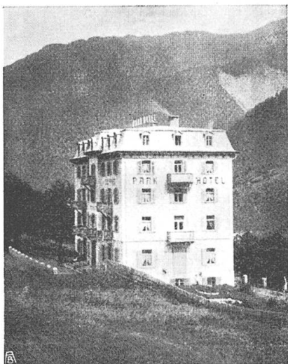
Abb. 14. Hotelkasten bei Compadials. Gegenbeispiel. Ein Steinwürfel, der in der Gegend störend wirkt. — Fig. 14. Hôtel à Compadials. Construction massive qui contraste avec le paysage; un bloc informe de pierre au sein d'un paysage admirable!
