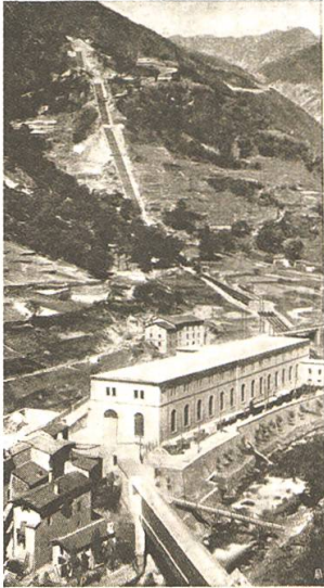
Abb. 9. Kraftzentrale Campocologno des Kraftwerkes Brusio. Die Druckleitung wirkt, ein unvermittelter Eingriff in die Landschaft, kahl und störend. Fig. 9. Installation principale à Campocologno des usines électriques de Brusio. Les conduites hydrauliques, en coupant brutalement les pentes de la montagne, détruisent l'harmonie du paysage.
