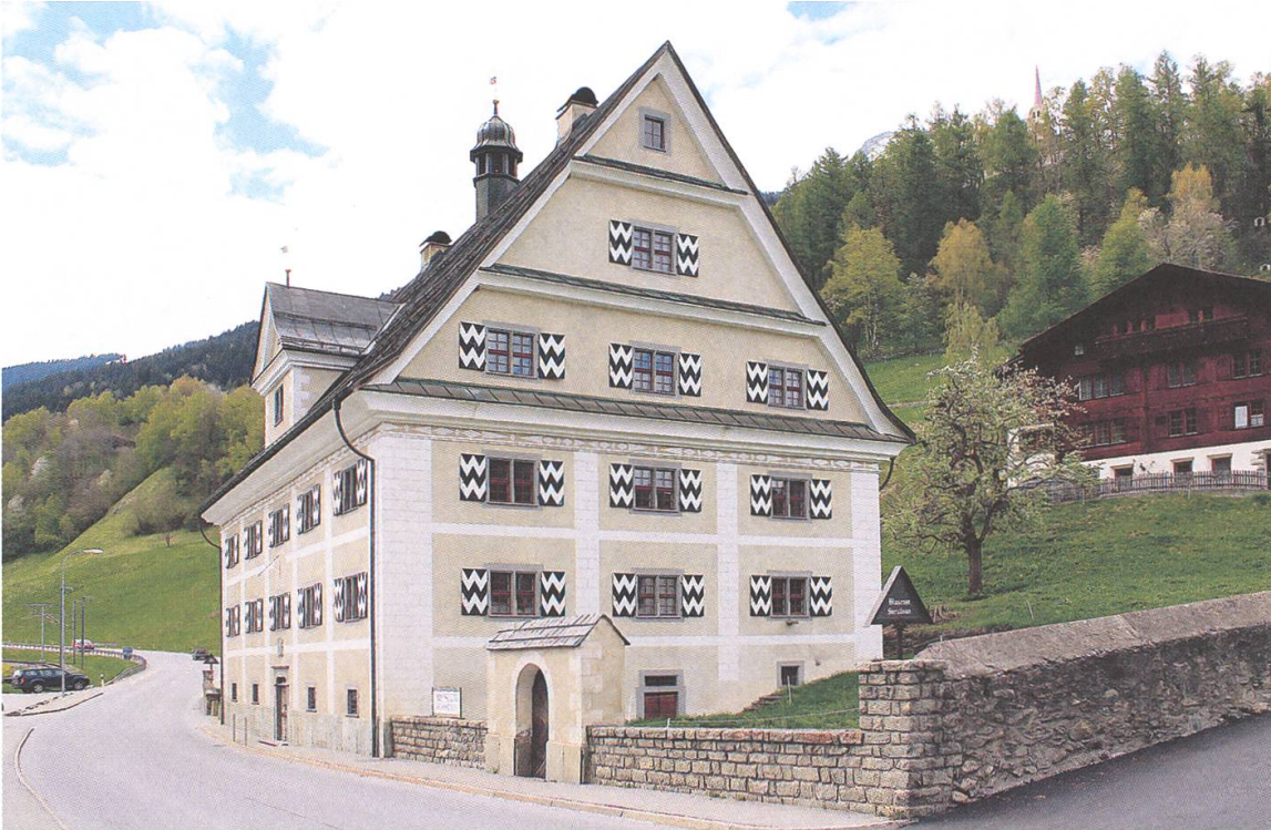
Abb. 24: Die Cuort Ligi Grischa in Trun. Der Abt von Disentis stellte den ehemaligen Klosterhof dem Grauen Bund als Gerichts- und Verwaltungssitz zur Verfügung. Hier versammelte sich auch der Bundestag. Das Gebäude wurde 1674–1679 erbaut (Denkmalpflege GR).
