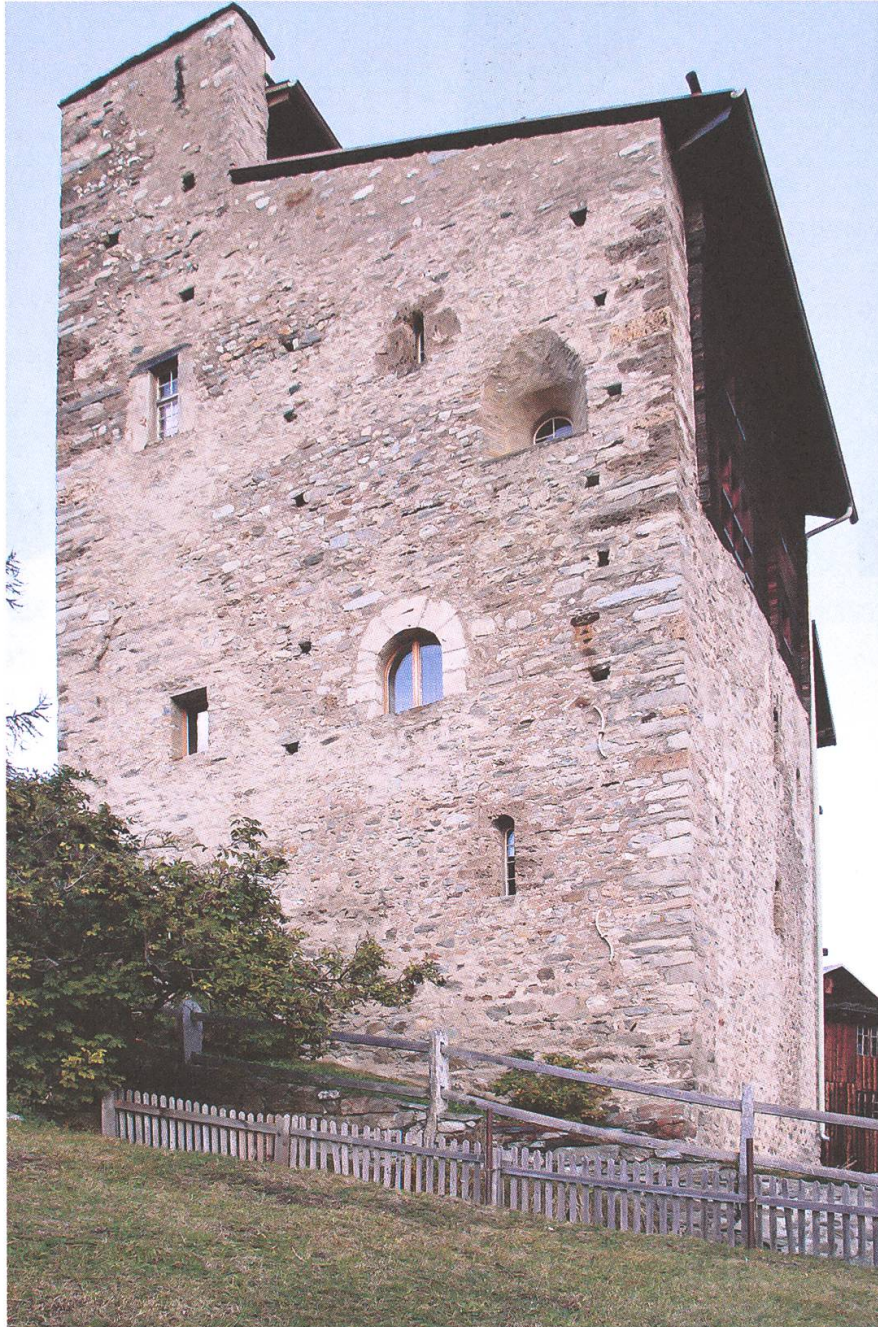
Abb. 12: Wohnturm der Herren von Lumerins in Lumbrein (14. Jh.). Der Stammsitz der Familie gelangte nach deren Niedergang im 16. Jh. an die von Capaul (Denkmalpflege GR).
