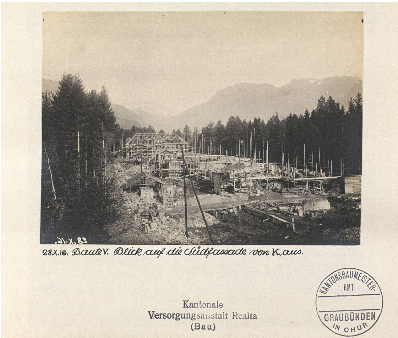
Bild 6: Die Anstalt Neu-Realta im Bau (1916).
