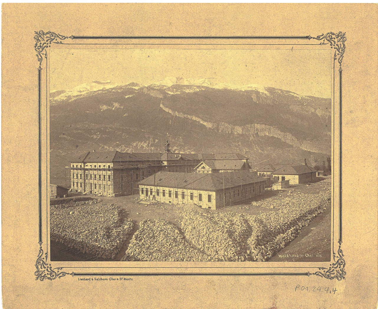
Bild 2: Die Klinik Waldhaus während der Bauphase um 1891.
