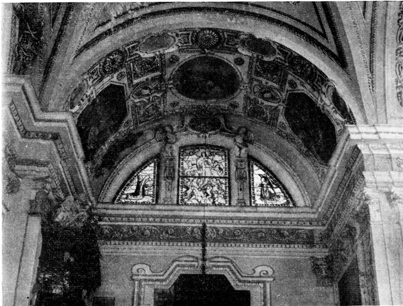
Parte del coro della chiesa della Madonna del Ponte Chiuso
