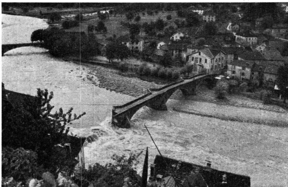
Roveredo. Il Ponte di Valle mutilato dopo la piena 8 VIII 1951 (Foto Casagrande)
