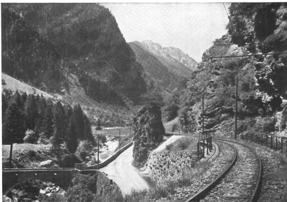
Ponte del Sasso sotto Soazza.
