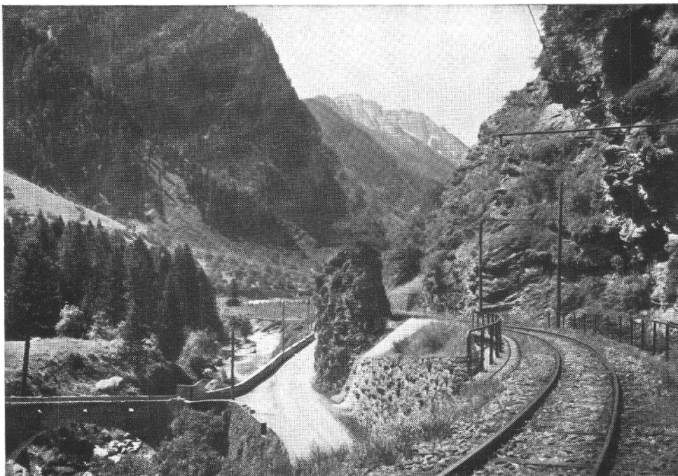
Ponte del Sasso sotto Soazza.
