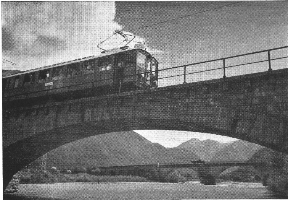
Ponte sulla Moe- sa, tra Castione e Molinazzo.
