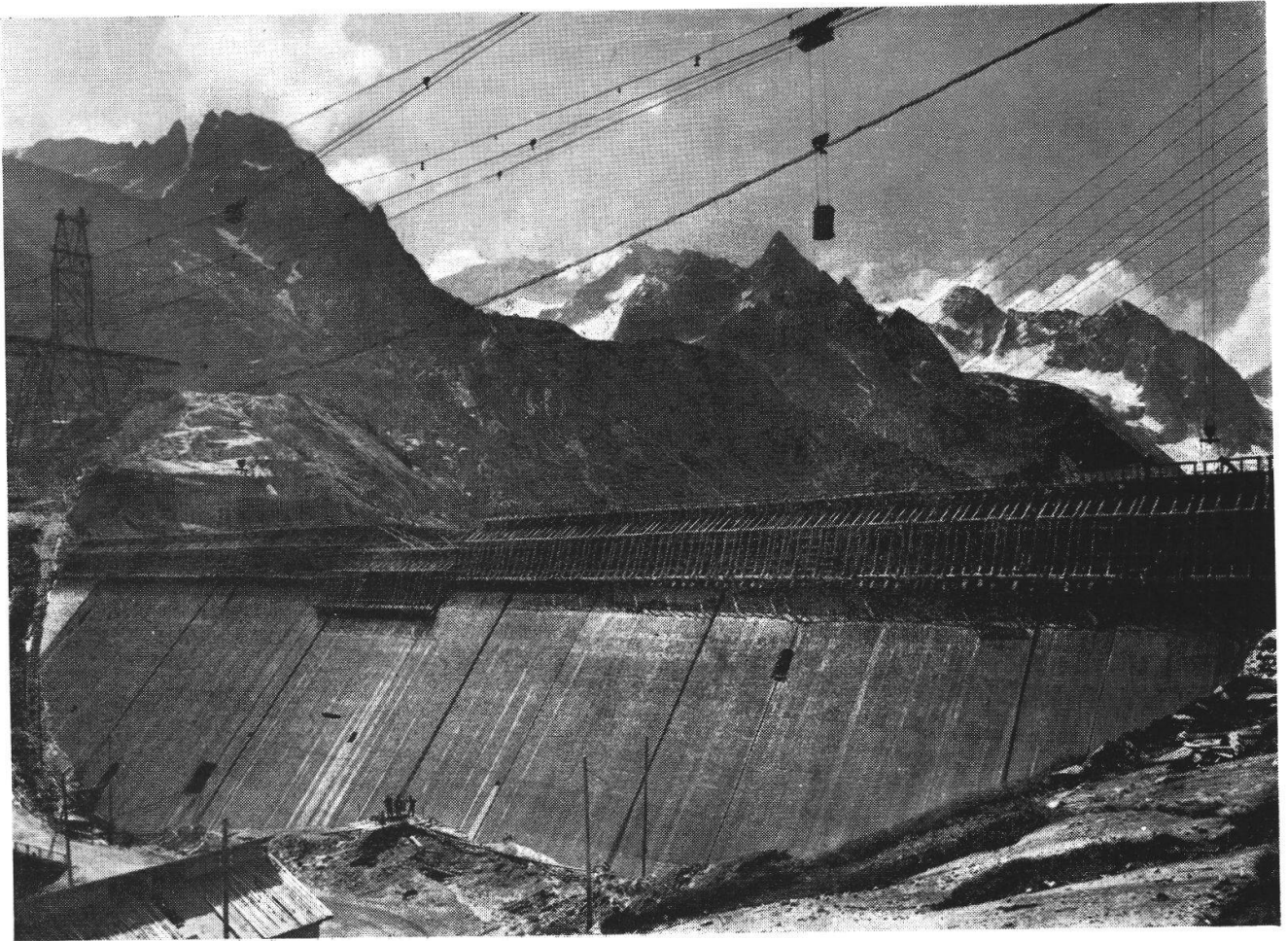
La diga dell'Albigna in costruzione.
