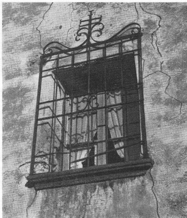
Fig. 26 - Inferriata della finestra di una stüa a S. Carlo.
