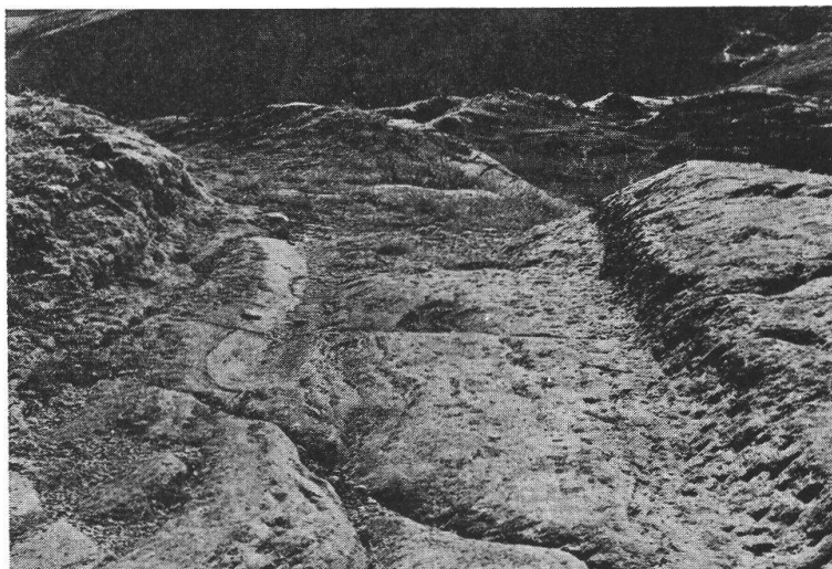
Fig. 22 Questa roccia venne incavata in modo da tener incastrato il selciato; si trova allo sbocco sud del lago sulla sommità del passo del San Bernardino. Vista da nord. Probabilmente romano. Piano: N.
