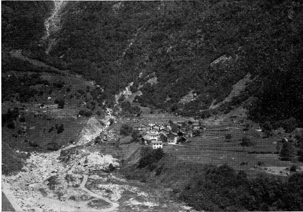
Andergia e la Moesa dopo un'alluvione
