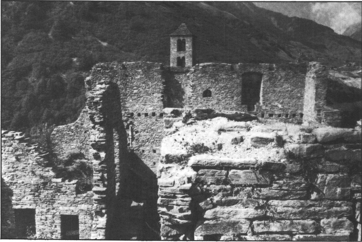
Resti della cucina, del mastio e del palazzo da sud-est (Fot.: Hauswirth)
