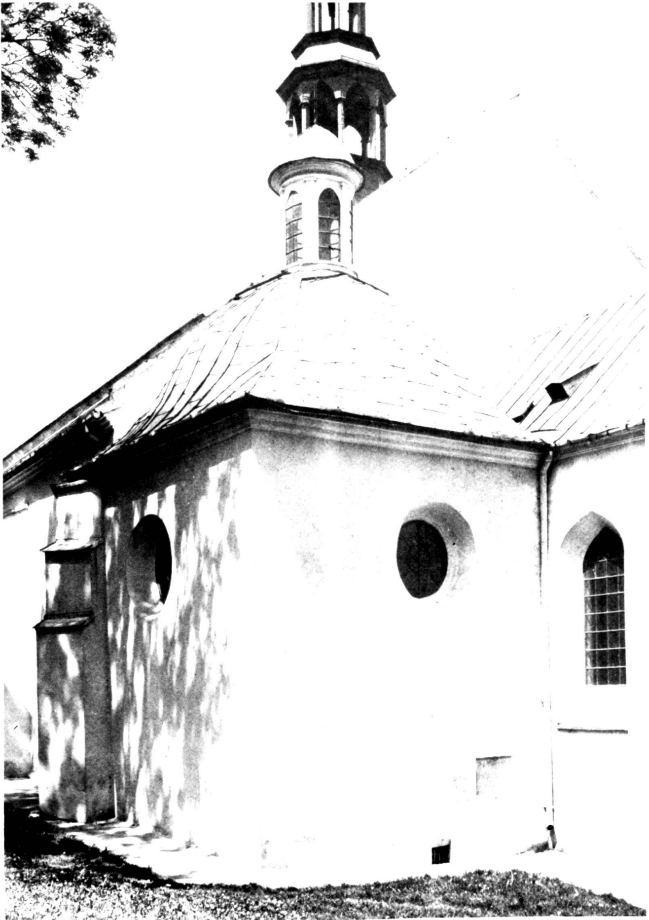
Checiny, Cappella Fodiga, prospetto da Sud-Est
