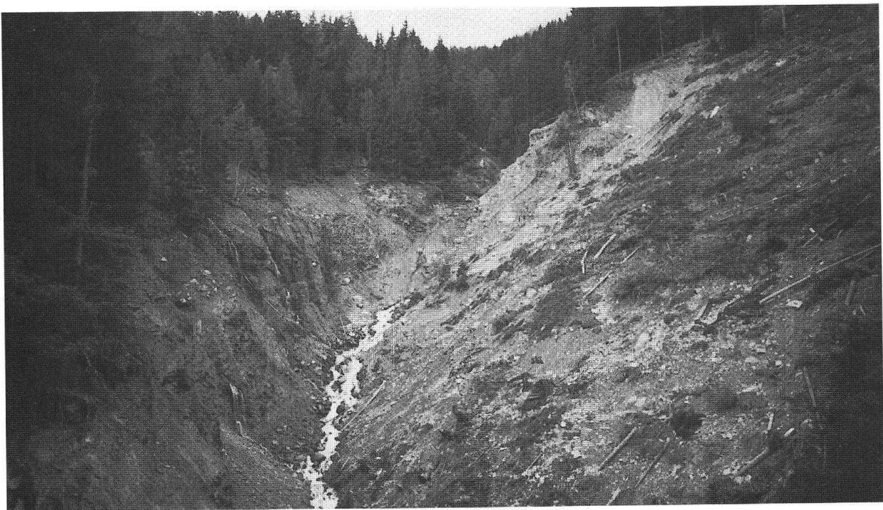
Il medesimo tratto fluviale dilavato con i fianchi resi instabili dalle due catastrofi del 1987. La profondità erosiva in questo punto raggiunge gli 8 metri circa, e la capacità erosiva 300 \text{ m}^3/\text{m} .
