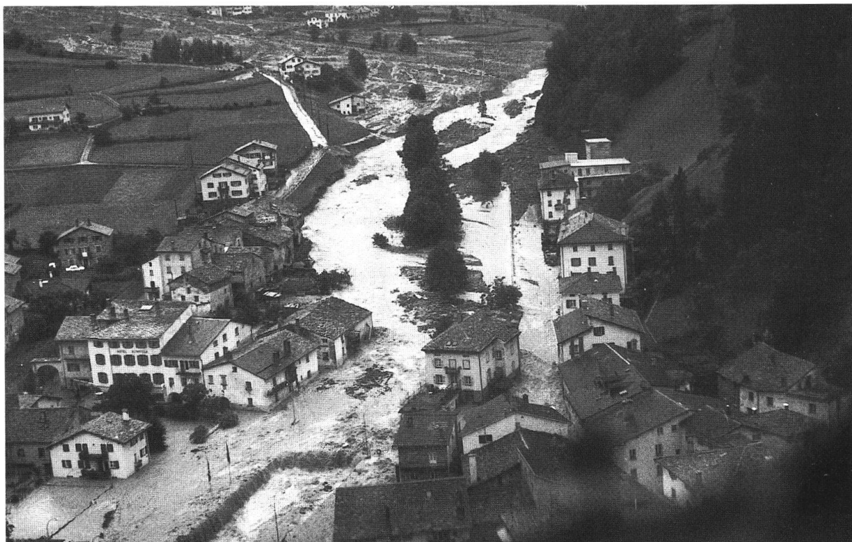
Situazione del fiume Poschiavino il 19 luglio 1987 al mattino nella parte nord di Poschiavo. Il letto del fiume riempito da detriti deviò l'acqua nelle strade del paese. Sopra a sinistra è visibile il cono della Val Varuna coperto da detriti delle mure. (Foto aerea di A. Riedo, Poschiavo)
