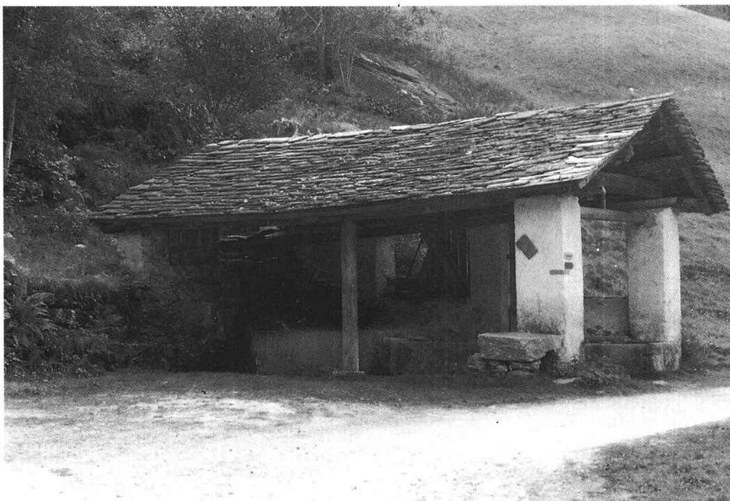
La «funtäna di Zop» a Bondo. Il bel tetto con le piode di gneiss copre una serie di vasche costruite con lastroni di roccia.
