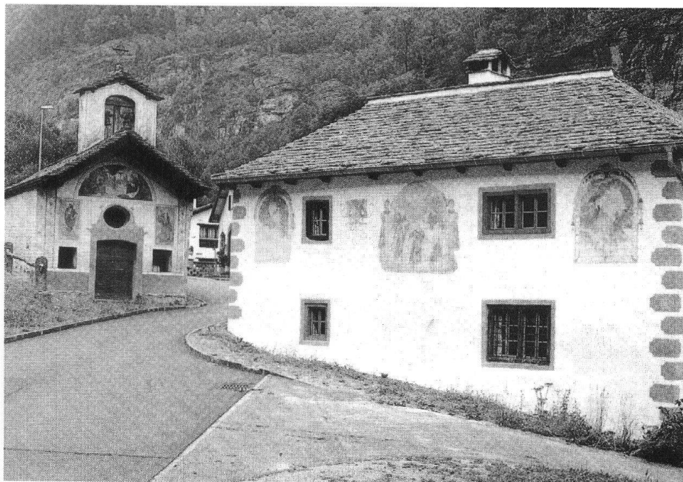
Cappella di Loreto e Ca' del Pin dopo il restauro
