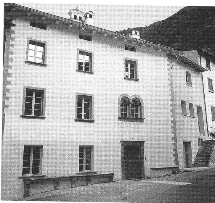
e dopo il restauro
