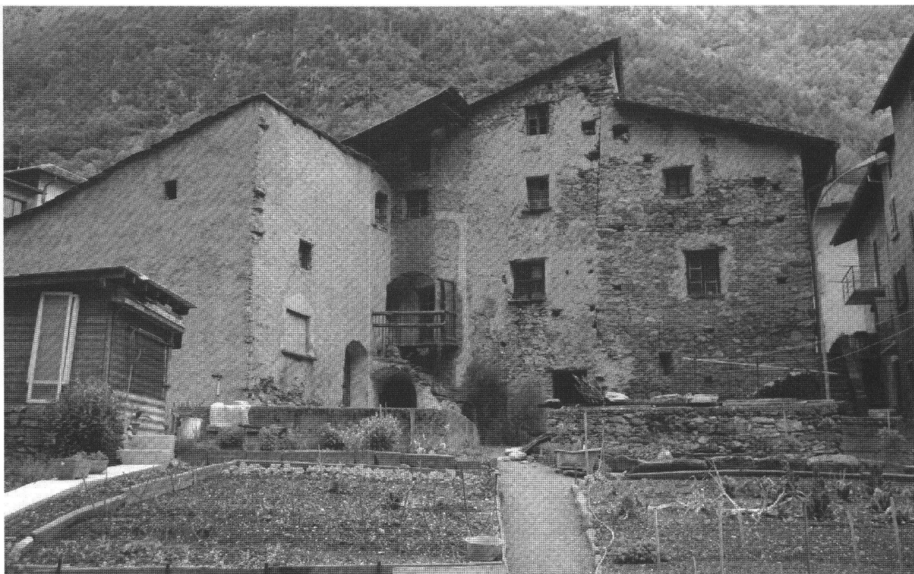
Campascio: Il conglomerato di edifici civili e rustici a Campascio in fondo alla Val Poschiavo è un rarissimo esempio di varie connotazioni tipologiche dell'edilizia rurale fra il Trecento e il Settecento
