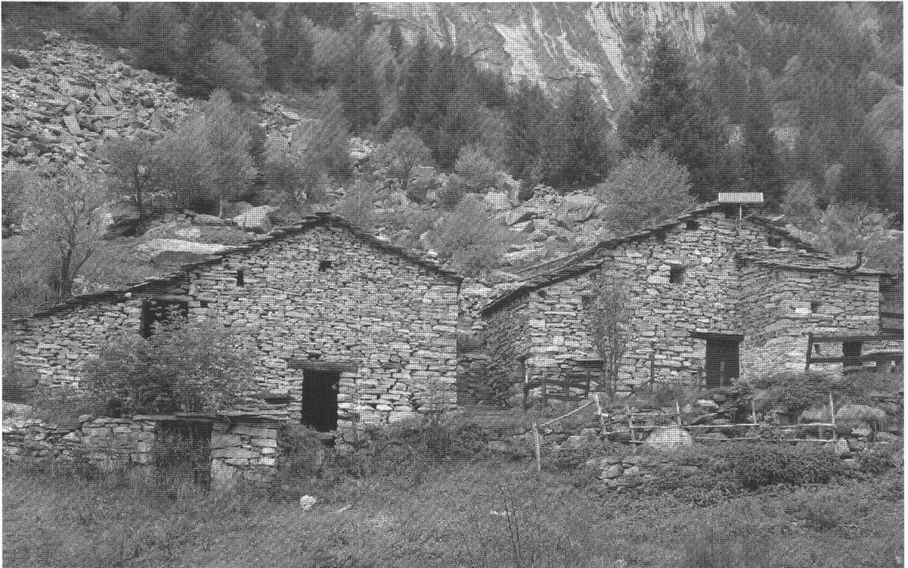
Savogno: L'abbandono dell'alpe Alpiggia costruito interamente in muratura a secco è marcato dagli inconsueti e rigogliosi alberelli
