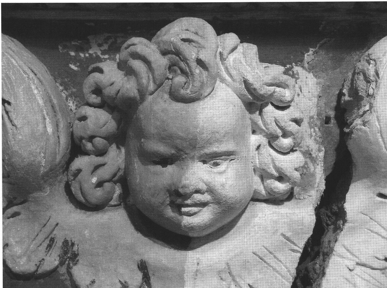
Dettaglio della cornice di un altare, durante la rimozione degli strati di scialbatura sovrastanti lo stucco originale
