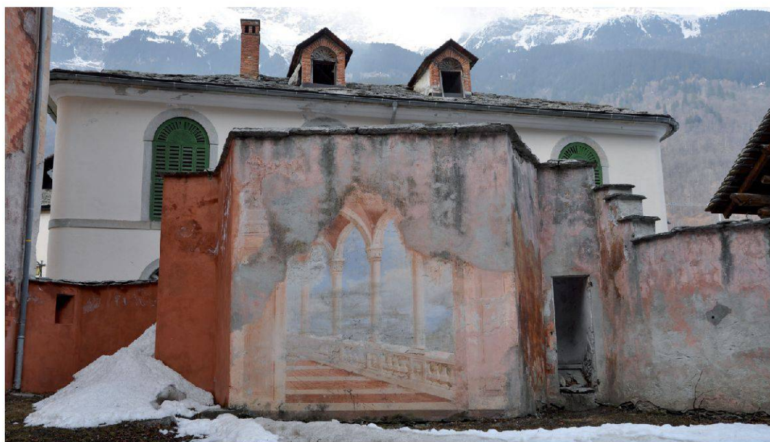
N. 3. La Rimesa vista dal Giardino Castelmur. In primo piano il muro del giardino dipinto con una scena architettonica della metà dell'Ottocento.
