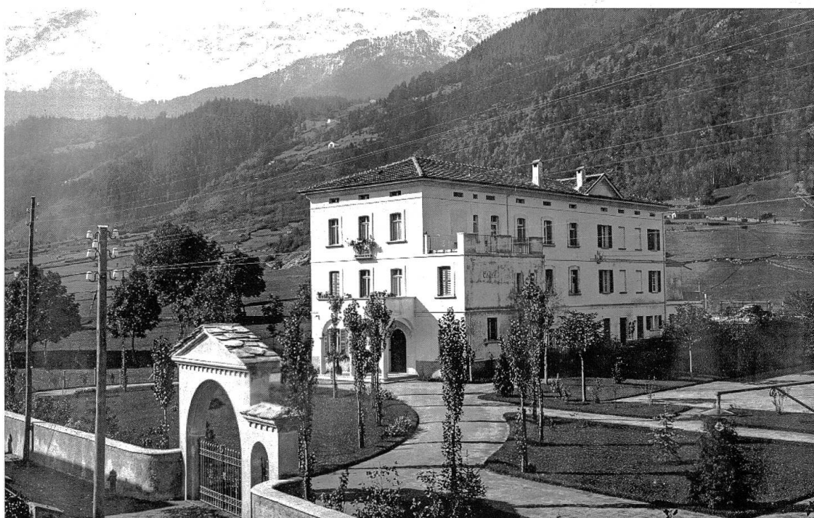
Poschiavo, via da Clait, sede della società idroelettrica delle Forze Motrici Brusio negli anni del primo dopoguerra (Fonte: Archivio fotografico Luigi Gisep – Società Storica Val Poschiavo)
