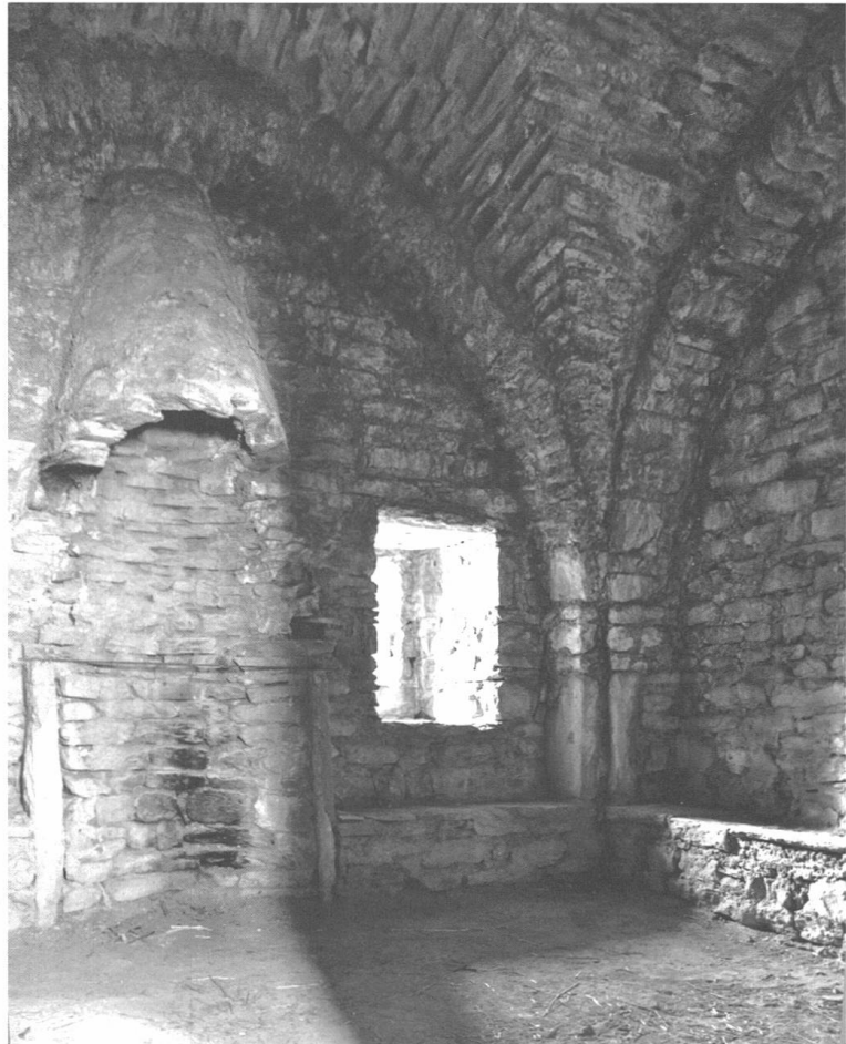
Figura 8: Castello di Santa Maria in Calanca. Piano superiore con volte a crociera e cappa del camino a forma di mezzo pan di zucchero (Johannes Meyer, Fotostiftung Graubünden).
