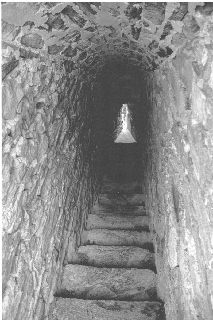
Figura 9: Castello di Santa Maria in Calanca. Scala con volta a botte nello spessore del muro (Johannes Meyer, Fotostiftung Graubünden).
