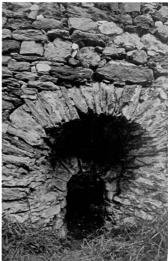
La calchera di Prato Leventina, ben restaurata ma non rimessa in funzione. L'imbocco di questa fornace è stato costruito con pietra ollare, usata anche per la bocca dei forni da pane
