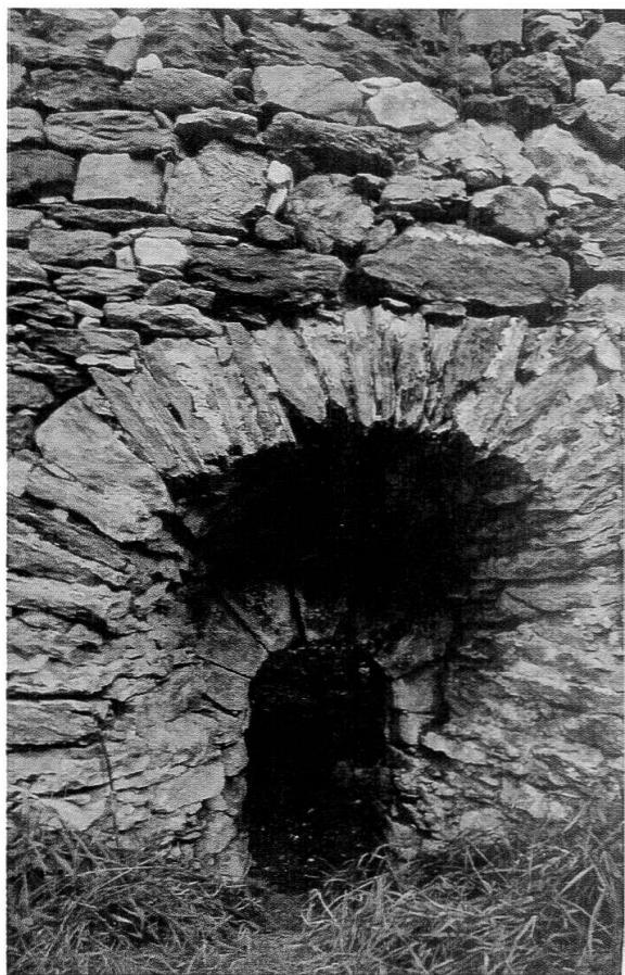
La calchera di Prato Leventina, ben restaurata ma non rimessa in funzione. L'imbocco di questa fornace è stato costruito con pietra ollare, usata anche per la bocca dei forni da pane
