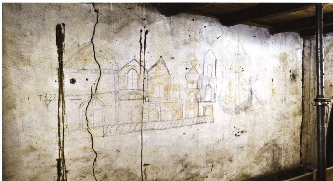
[7] Casa Guberto, Soglio, piano superiore, deposito, parete nord (panoramica). Foto: ADG/SAG 2020
