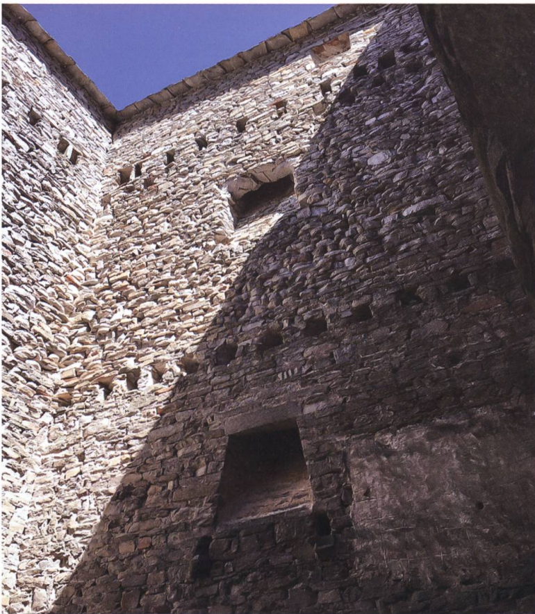
La parete interna nord. Al livello del 4° piano le tracce dell'esposizioni al calore sono ben riconoscibili. Foto: ADG/SAGR
