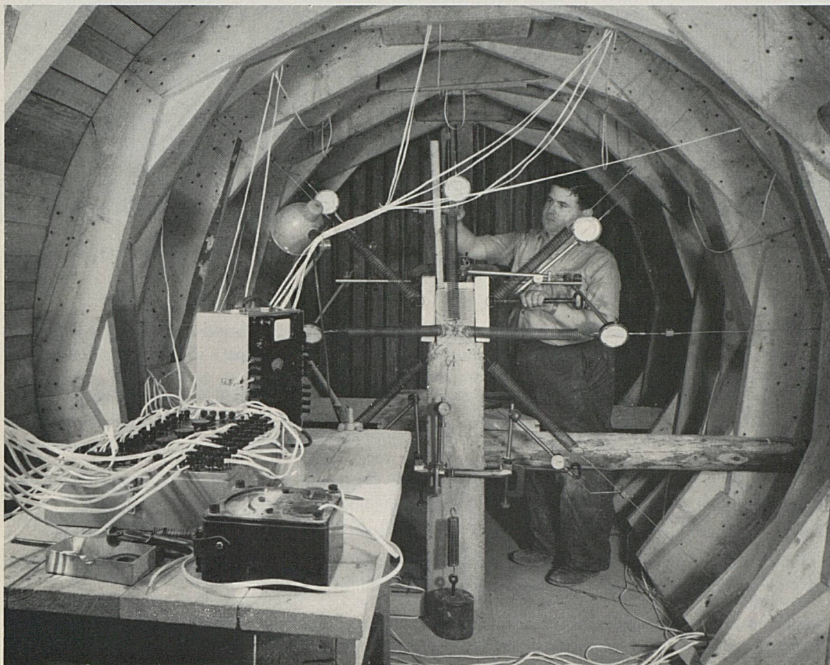
Mesure des contraintes dans le tunnel à câbles de la nouvelle installation d'enclenchement de Zurich
