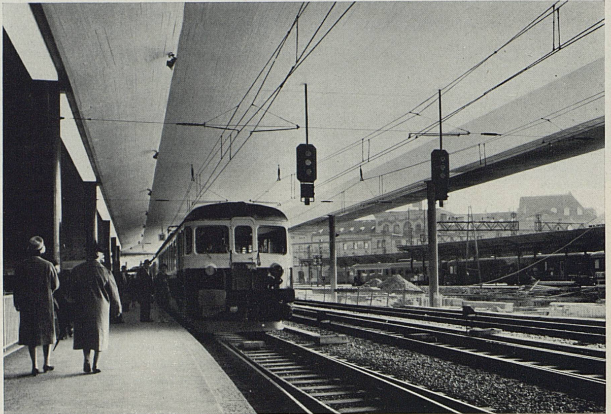
Le nouveau quai 6 de la gare de Berne est déjà en service
