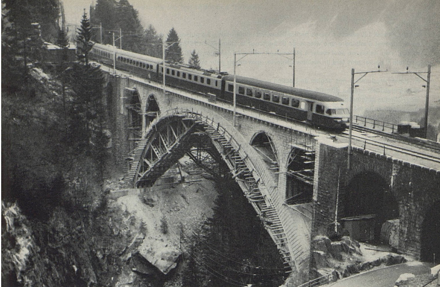
Sur la ligne du Saint-Gothard, la nouvelle rame électrique Trans-Europ-Express franchit le pont médian – actuellement en transformation – sur la Meienreuss
