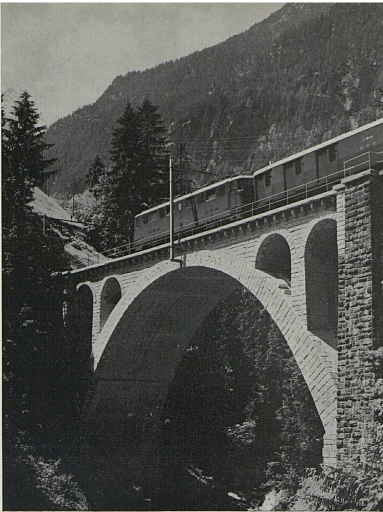
Sur la ligne du Saint-Gothard: un des nouveaux ponts en béton, avec revêtement en pierre naturelle
